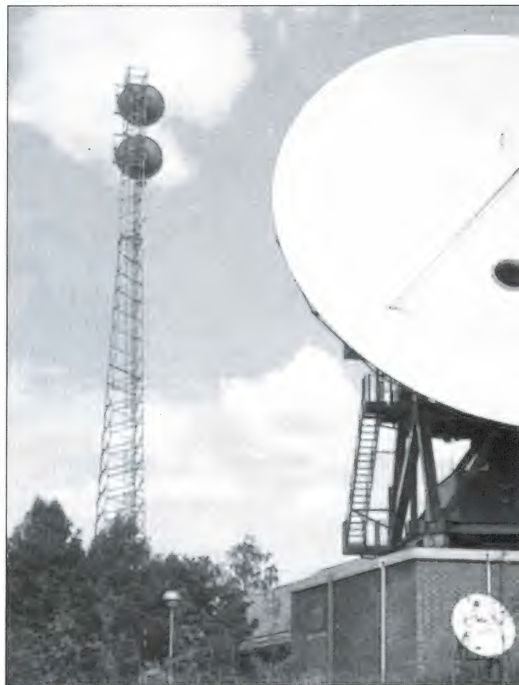
Grondstation van de Zweedse PTT in Ågesta (bij Stockholm); 18 meter-parabolantenne.
